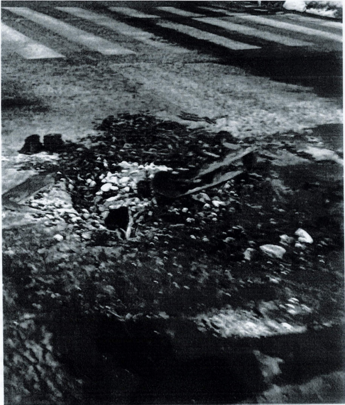
Calle Obsidiana y Puerto del Carmen.
