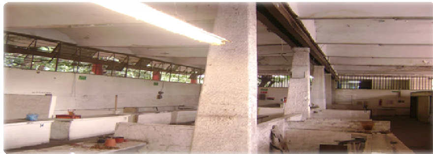
Mercado José Clemente Orozco. (desalojado)
