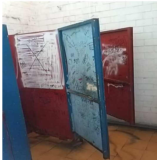
Sanitarios del Mercado Plutarco Elías Calles
