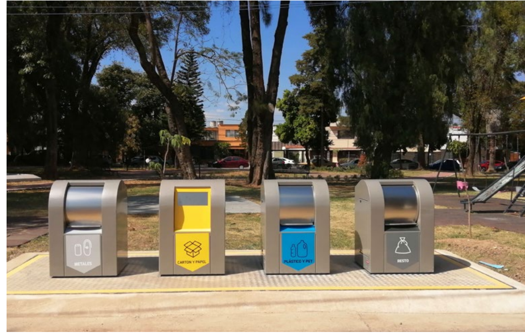
Imagen 19. Punto Limpio soterrado. (DMA, 2020)
