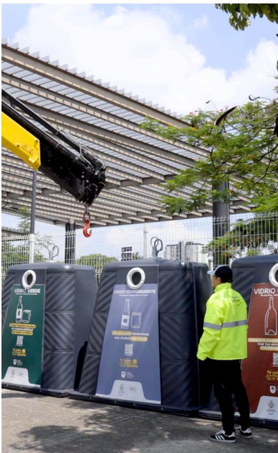
▲ Sistemas de elevación y vaciado instalado en los contenedores de acopio de vidrio. (DMA, 2024)
