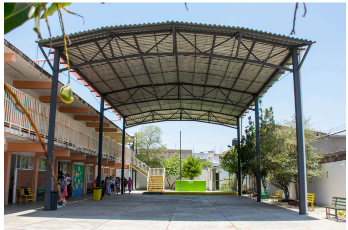
Techo instalado en escuela pública, elaborado con reciclaje de Tetra Pak®. (DMA, 2024)
