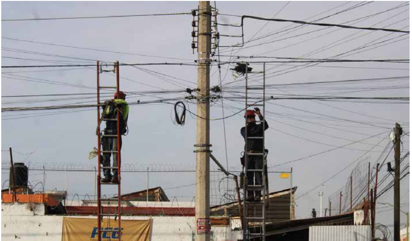
En tres años de gobierno, hemos eliminado 283 toneladas de cableado obsoleto, equivalentes a 2,373 kilómetros lineales.
