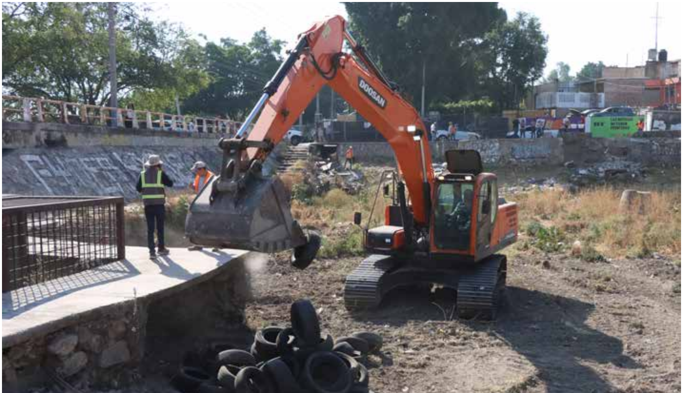
Previo al temporal de lluvias, llevamos a cabo la limpieza y desazolve de canales y vasos reguladores.
