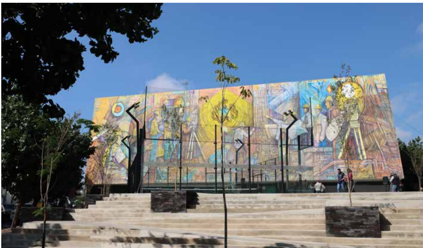
A partir de su renovación, el edificio de Obras Públicas se convirtió en un inmueble con alta eficiencia energética.
