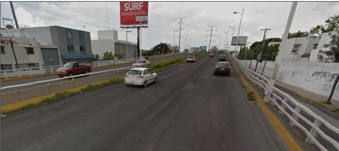
Av. Vallarta en su cruce con Inglaterra al poniente del subdistrito urbano 06 "Circunvalación-Vallarta" en esta arteria las superficies son de concreto hidráulico.
