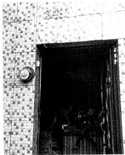
Imagen No. 6 Inundación casa habitación: María C. Balcalari 3490, colonia Valentín Gómez Farias
