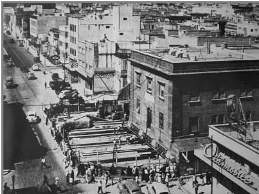
Desplazamiento del Edificio de la Telefónica Mexicana, 1950.
