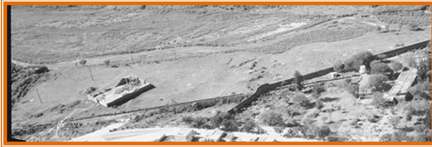
Una fotografía de 1965 donde se aprecia parte de acueducto que salía de la presa de Zoquipan a la Fábrica de Atemajac, esta parte el acueducto está detrás de la fábrica.
