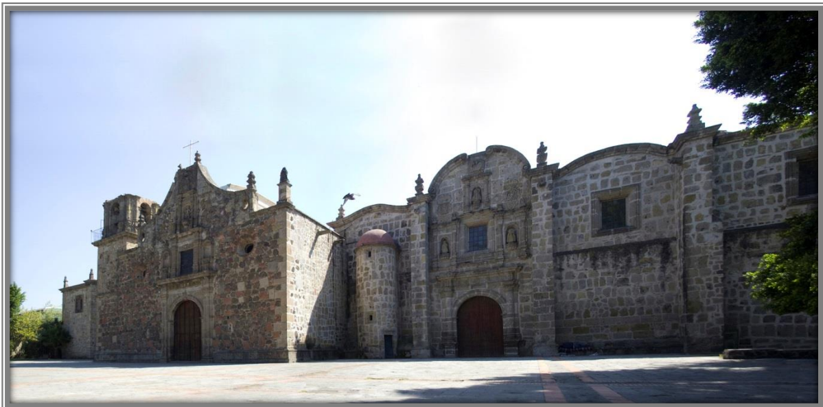
Jardín de San Sebastián y explanada, al costado oriente de la calle 28 de Enero en el barrio de Analco.
