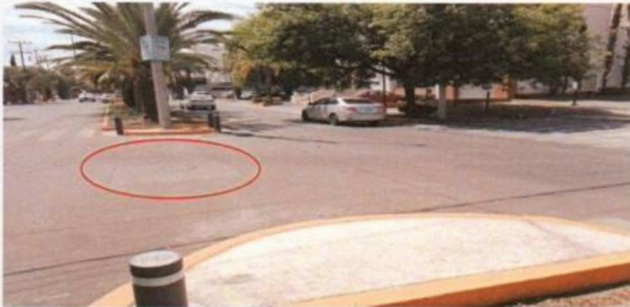
Imagen de referencia tomada el 12 de marzo de 2024, donde se verifica una de las áreas en las que no se realizó el proceso de carpeta asfáltica siendo el lado poniente punto de la Av. Francisco Javier Gamboa cruce con la calle José Gpe. Montenegro, cota 0+140.00 del croquis anexo en la Est. 3, siendo de 1.02 metros cuadrados de un total observado de 6.16
