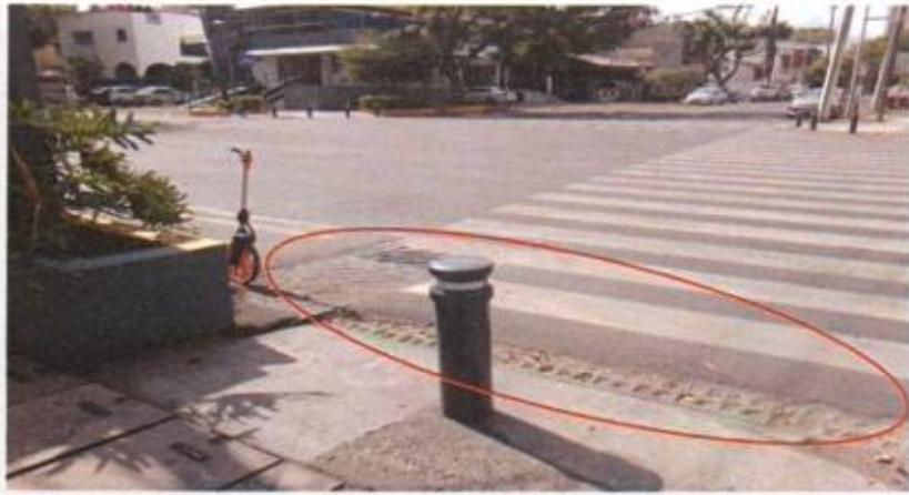
Imagen de referencia tomada el 30 de noviembre de 2023, donde se verifica una de las áreas en las que no se realizó el proceso de fresado, siendo el punto de la Av. Francisco Javier Gamboa esquina con la calle Manuel López Cotilla, lado oriente, cota 0+660 del croquis anexo en la Est. 1, siendo de 2.10 metros cuadrados de un total observado de 743.55
