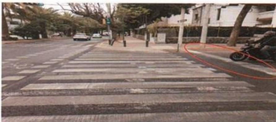
Imagen de referencia tomada el 20 de junio de 2024, donde se verifica una de las áreas donde se realizó parte del proceso de línea de alto de 60 cm. de ancho del punto de la Av. Francisco Javier Gamboa al cruce con la calle José Guadalupe Zuno, cota 0+320.00 del croquis anexo en la Est. 7F, se localizó una línea de 7.85 metros lineales donde se generaron 2 líneas de 7.85 metros cada una, observando en el punto 7.85 Ml. de un total observado en la revisión de 46.49 Ml.
