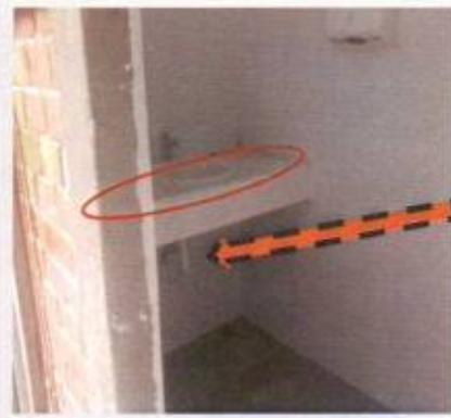
Imagen de referencia tomada el **24 enero de 2023**, en área de baños donde se verifica el suministro y colocación de 8 lavabos, con diferentes especificaciones al proyecto
