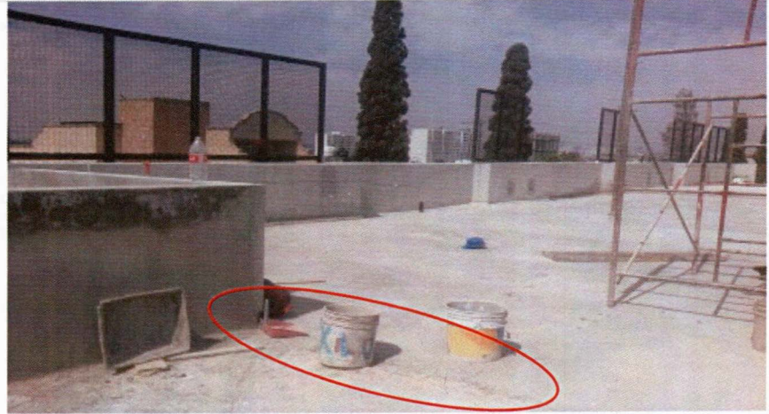
Imagen de referencia donde se aprecia la colocación del material descrito en el concepto DOP-016 sobre el hormigón preexistente.
