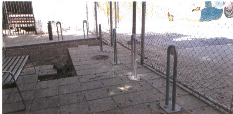
Imagen correspondiente al Concepto 0034 ejecutado en el Parque "Fray Luis de León" ubicado en Av. Justo Corro y Privada Fray Luis de León tomada el 04 de marzo del 2022.
