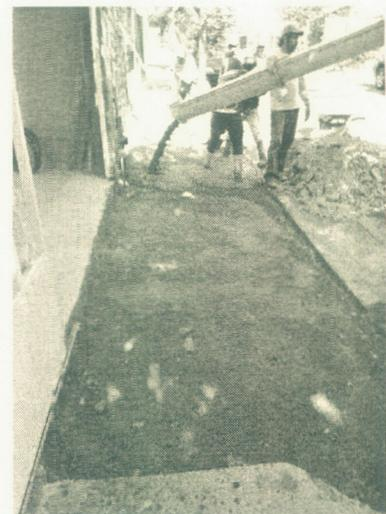
Imágenes tomadas en campo, donde la losa no cumple con las especificaciones del concepto, toda vez que se hizo con un espesor de 8 a 10 cm, mientras que el concepto especifica que debe ser de 15 cm.
