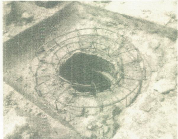
Imágenes tomadas del generador de la estimación 03 finiquito, donde el espesor o altura de la excavación de los pozos de visita son de 20 cm y no 27 cm.
