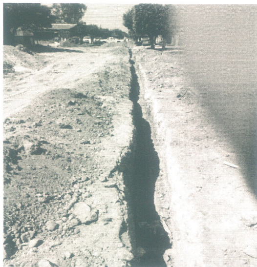
Excavación con equipo mecánico
