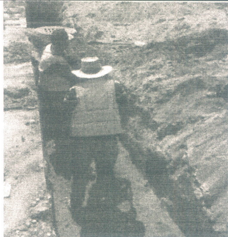
Relleno y compactación con material producto de excavación.
