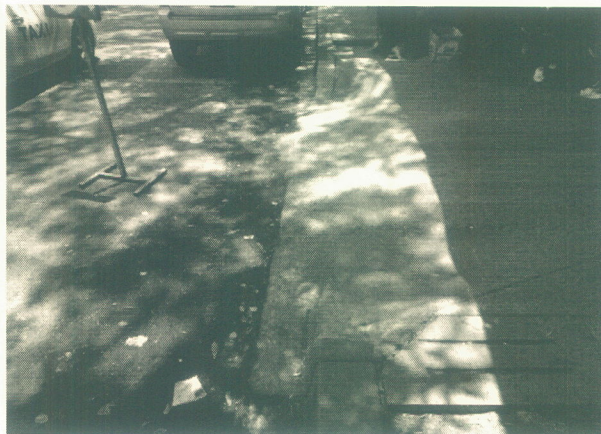
Forjado de Rampas Vehiculares en ingreso a patio
