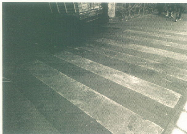
Concreto Hidráulico en Acceso a Patio
