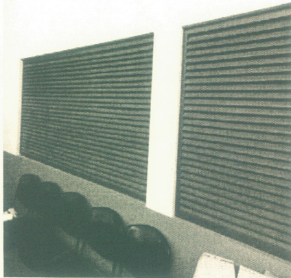
SUMINISTRO Y COLOCACION DE HERRERIA TUBULAR
