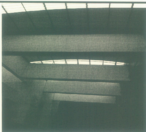
REHABILITACION DE LAMBRIN DE TABLAROCA
