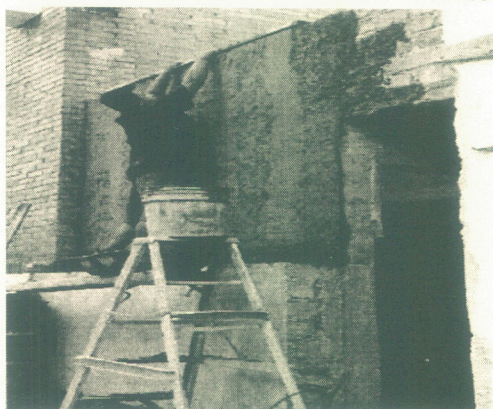
APLANADOS EN MUROS
