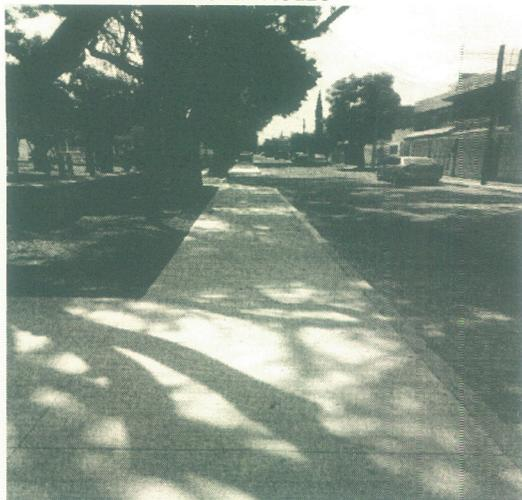
LOSA DE CONCRETO DE 10 CMS. DE ESPESOR
