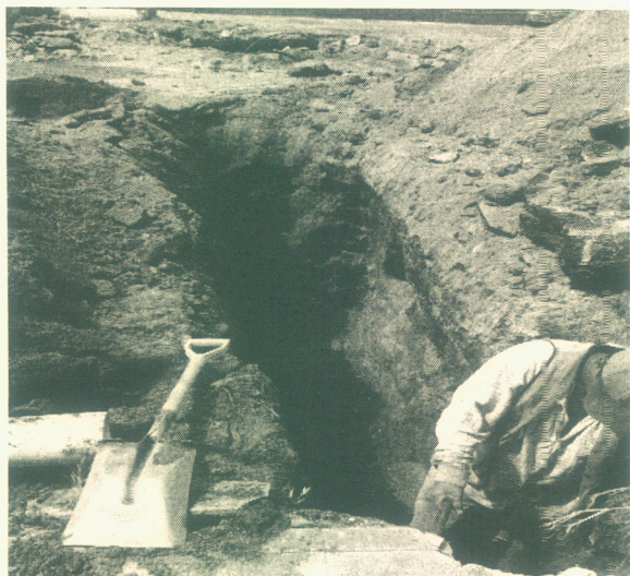
excavación manual para descargas domiciliarias
