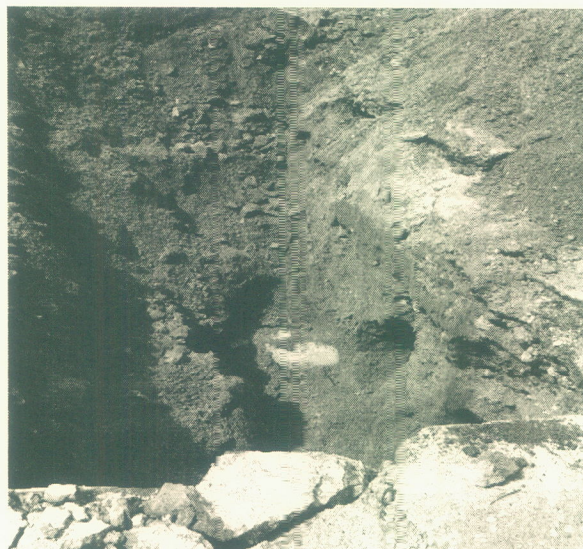
(socavación provocada por lluvias)
