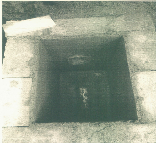
construcción de registro sanitario domiciliario para descargas
