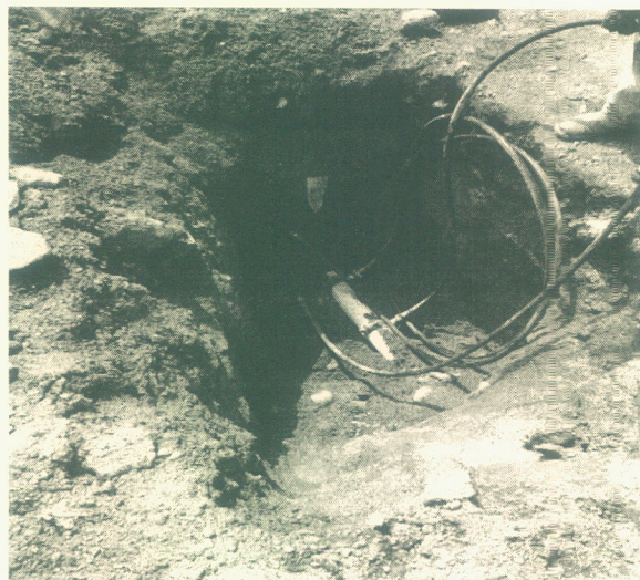
suministro y colocación de tomas domiciliarias
