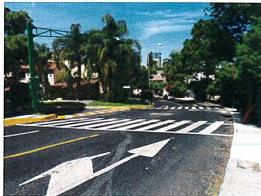
La Av. Circuito Madrigal la mitad de la Avenida corresponde al Municipio de Guadalajara y la otra mitad al Municipio de Zapopan, por lo que el Municipio de Zapopan aportó el asfalto de 2,110 metros cuadrados.
